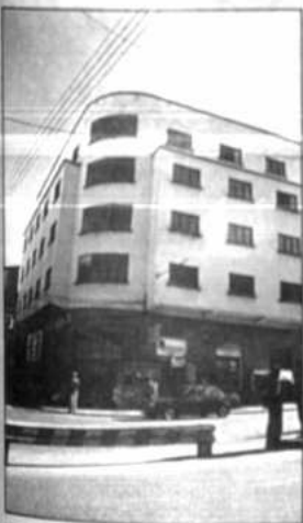
Edificio donde funcionaron las oficinas de Derechos Reales. Av. Montes y Bozo.
