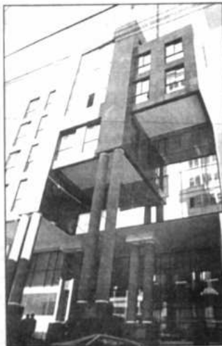
Nuevo Edificio central de los Tribunales.
