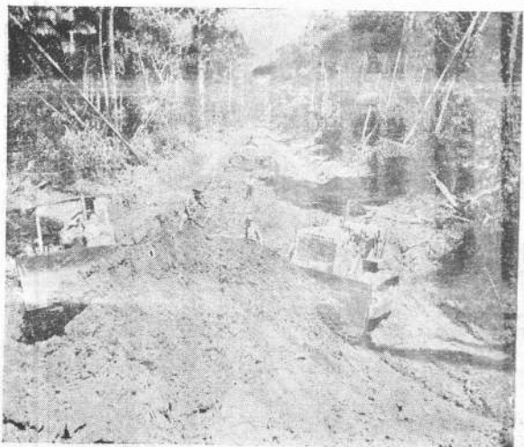
Construcción de caminos de acceso a las parcelas
