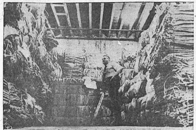
LISTO PARA ENTREGAR DOS MILLONES DE SACOS DE ARENA. — Robert Berg, vicepresidente de la Berg Bag Co., de Minneapolis, Minnesota. Inspección su abastecimiento de sacos de arena después de recibir una orden por 2 millones de éstos del Cuerpo de Ingenieros del Ejército preparándose para las inminentes inundaciones de la primavera. “Las comunidades tienen que suministrar la arena”, dijo Berg.
