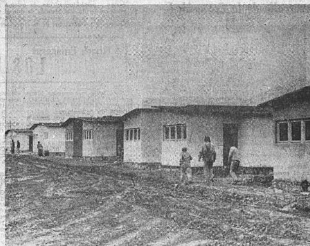
En la zona de Villa Dolores de El Alto, se acelera la conclusión de 220 viviendas que se entregarán en breve a varios sectores laborales. Falta pocos detalles para su conclusión.
