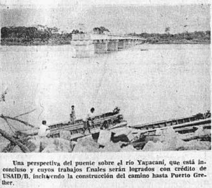
Una perspectiva del puente sobre el río Yacupani, que está en construcción y cuyos trabajos finales serán logrados con crédito de USAID/B. Iniciando la construcción del camino hasta Puerto Grether.
