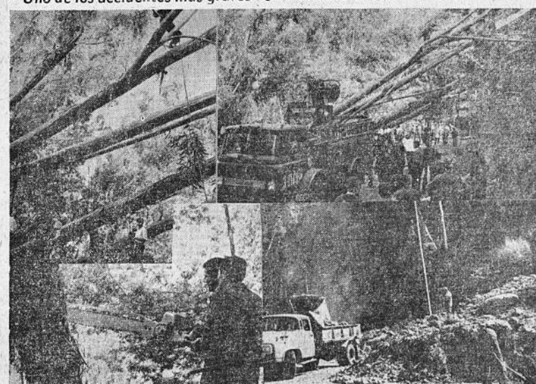
Hubo intenso trabajo en el sector afectado de hoy por un grave deslizamiento y desplome de árboles. La composición gráfica muestra cuatro aspectos, precisamente de la labor de limpieza que se realiza en el lugar. Se emplearon maquinarias, vehículos, herramientas y otros equipos. El trabajo fue febril y extenuante. Participaron autoridades de la Municipalidad, de Bomberos, cuadrillas de obreros, técnicos y gran cantidad de voluntarios.
