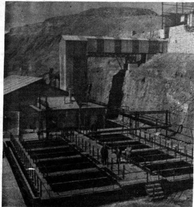
Vista general exterior de la planta mostrando la sección lixiviación y el circuito de alimentación de concentrados, lo que permitirá la obtención de metálico de bismuto con una pureza aproximada del 99.9 por ciento.
