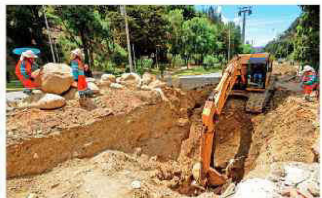
TRABAJOS. Maquinaria pesada realiza obras en una vía urbana.
