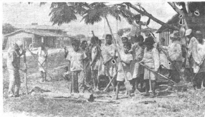
Una escuela construida dentro el sistema de "Auto-ayuda" por los pobladores de una junta vecinal de Trinidad (Beni) y el Desarrollo de Comunidades. Esta y otras tres más, serán entregadas en breve al servicio público.
