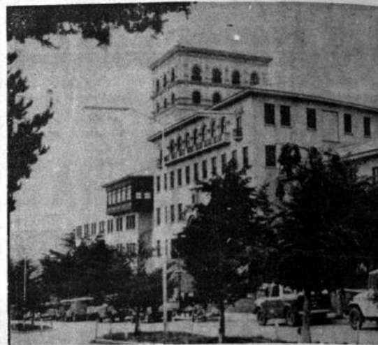
El edificio de la Universidad "Tomás Frías" de Potosí. Los estudiantes llevan adelante un movimiento revolucionario con la intervención a la Facultad de Ingeniería y la casa de estudios de la Villa Imperial—
