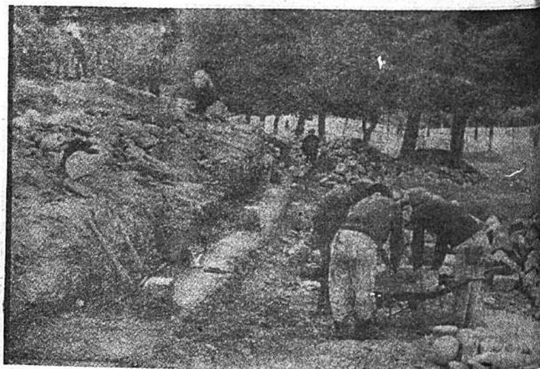
El drenaje del terreno evitará deslizamientos.
