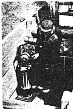
PARA COMPACTACION DE SUPERFICIES EN CONSTRUCCION DE CANALES, ZANJAS, CARRETERAS, EDIFICIOS, ETC. DE 450 A 630 GOLPES POR MINUTO.
