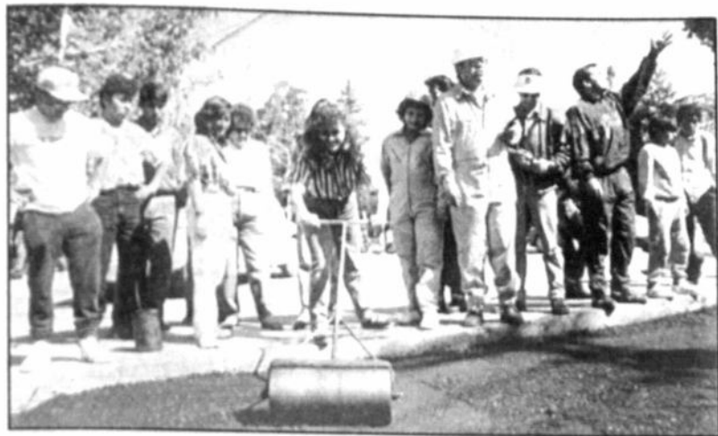
La alcaldesa inició ayer el asfaltado de la Plaza Humbolt, dentro del operativo de mejoramiento urbano en la Zona Sur.
