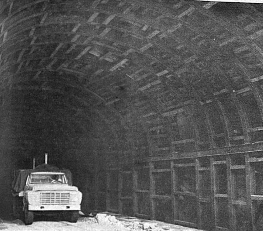
El "Peñón", mole de granito perforado en unos 180 metros de longitud arriba, está entre Cochabamba y San Jacinto. El túnel está siendo revestido con vigas de acero y cemento. Abajo, el puente sobre las aguas del río Vinto, proyecto vial Cuatro.
