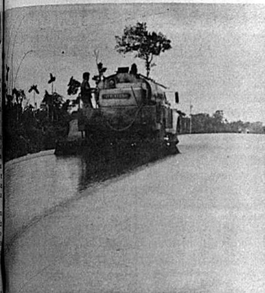
del proyecto caminero UNO que conduce a Puerto de Inimay. La obra de imprimación asfáltica es rociada por un ve-
