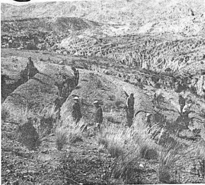
Cuadrillas de trabajadores municipales del Departamento de Reforestación cavando trincheras en la zona de Llojeta para defender los suelos de la erosión con la detención de las aguas pluviales que servirán además para la plantación de árboles.
