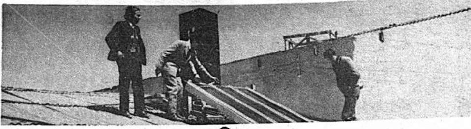
Calefones solares, instalados en el techo del edificio central del Laboratorio, permiten lograr abundante agua a considerable temperatura. Se proyecta construir, con materiales nativos, refrigeradores que funcionan con energía solar.
