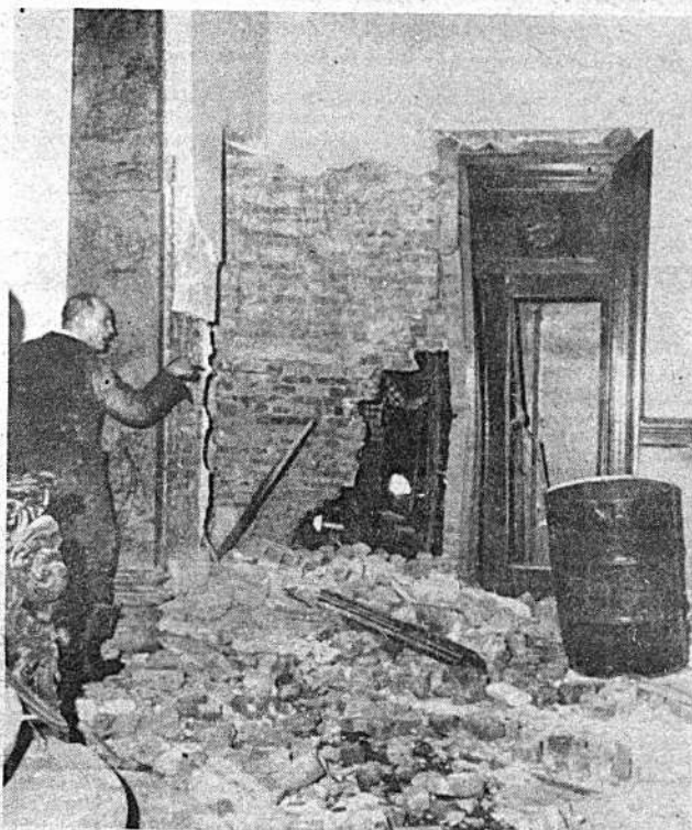
EXPLOSION. — Un policía señala el lugar donde se produjo la explosión ocurrida en el cuartel de la policía de Nueva York en la céntrica calle 240 de Manhattan. La explosión produjo la caída del segundo piso del edificio. (AP Wirephoto)
