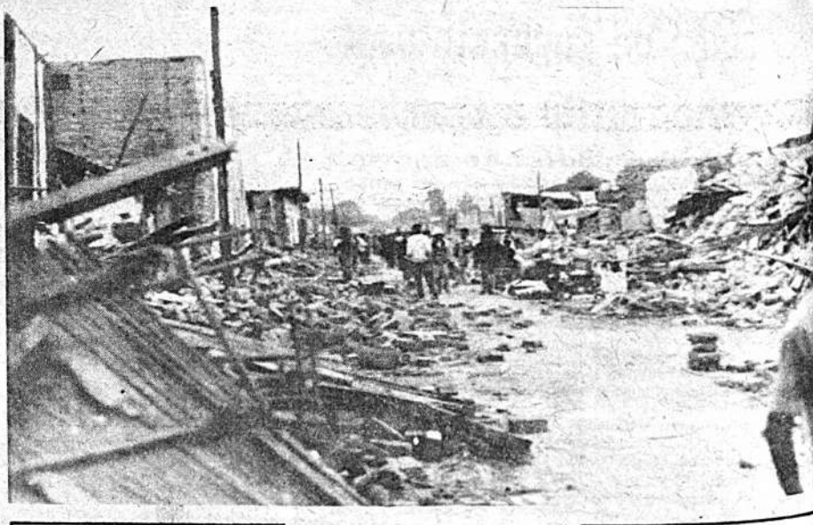
ESCOMBROS. Residentes caminan a través de las calles llenas de escombros en Huancayo, Perú, después del terremoto que azotó esas regiones. A decir de las propias autoridades, los daños son incalculables y el número de muertos podía alcanzar a los 80.000. Varias ciudades quedaron enterradas totalmente, como el caso de Yungay. (AP Wirephoto).
