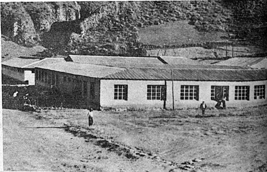
Vista del edificio de la Escuela Normal Rural "Franz Tamayo" de la localidad de Villavieja, inaugurado recientemente por el Ministro de Agricultura y Asuntos Campesinos, general León Kolle Cueto. La importante obra fue construida con la cooperación técnica del Programa de Desarrollo de Comunidades y el campesinado de la región.
