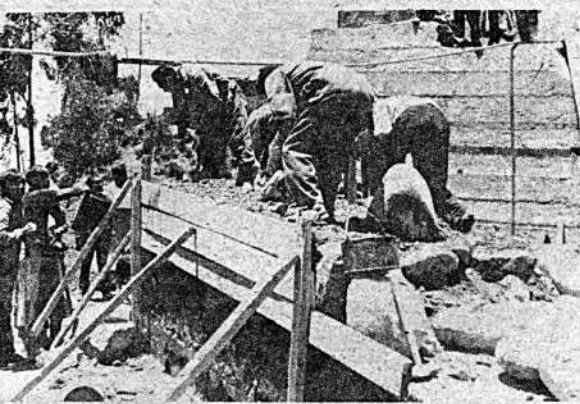
-Vecinos de Tembladerani construyen un puente para vehículos sobre el río Cotahuma. Asesora y orienta el trabajo el Departamento de Acción Comunal.
