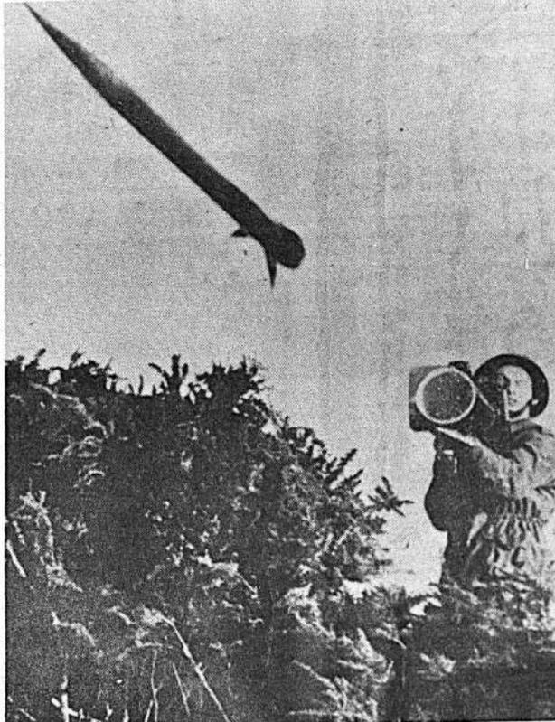
**HOMBRE COHETE.**— Cohete lanzado mediante lanzador portátil por un soldado británico durante una prueba en Aberdeen, Escocia. Llamado sistema Blowpipe, el equipo pesa solamente 40 libras. Después del lanzamiento, el cohete es dirigido por un comando radial generado por los soldados que lo usan. (AP Wirephoto).
