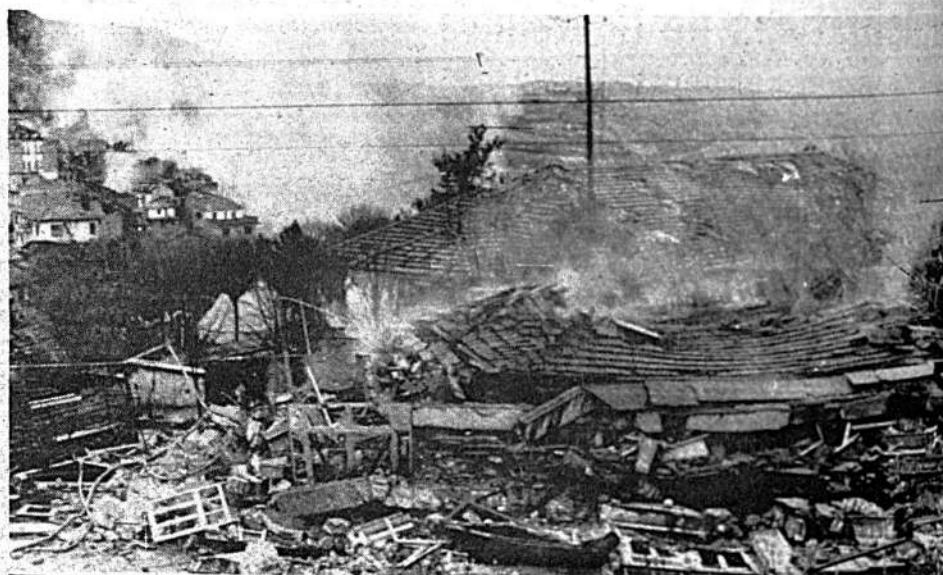
DESASTRE. — La foto fue captada en Gediz, ciudad turca asolada por un fuerte terremoto la semana pasada. Una casa se derrumba ante el movimiento de la tierra, sobre otras más pequeñas que ya estaban en escombros. (AP Wirephoto).—
