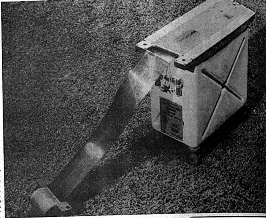
**INSTRUMENTO LUNAR.**— Este instrumento, llamado experimento para medir partículas cargadas de electricidad, estudiará en la Luna la distribución de la energía y las variaciones de tiempo de los flujos de protones y electrones, cuando la superficie de la Luna es bombardeada por el viento solar. También medirá los rayos cósmicos solares de baja energía, cuando hay erupciones o explosiones solares. El instrumento será transportado en la nave Apolo 13. (Foto USIS).
