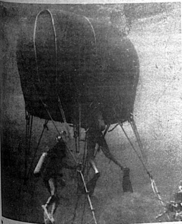
CASA BAJO EL MAR.— Buzos trabajan cerca de su "casa" infalible, 10 metros bajo el mar. Es de goma montada sobre una armazón rígida de metal. Se la infla a mayor presión que el agua y se la fija al lecho del mar mediante cables conectados a una lase de acero. La unidad de "soporte vital" absorbe el dióxido de carbono y provee oxígeno a los buzos que viven en la casa, donde además, hay luz, calefacción, es vivienda, laboratorio y taller.
