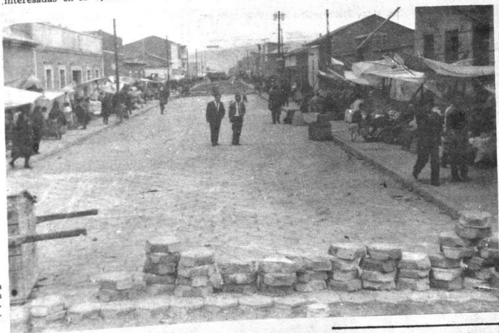
ORURO, (HOY). Dentro del programa de obras públicas que realiza la Alcaldía de esta ciudad, está previsto el ensancharse de varias arterias urbanas. En la foto, la primera cuadra de la calle Bolívar. Estas obras, iniciadas semanas atrás, han merecido pleno respaldo de los pobladores orureños.
