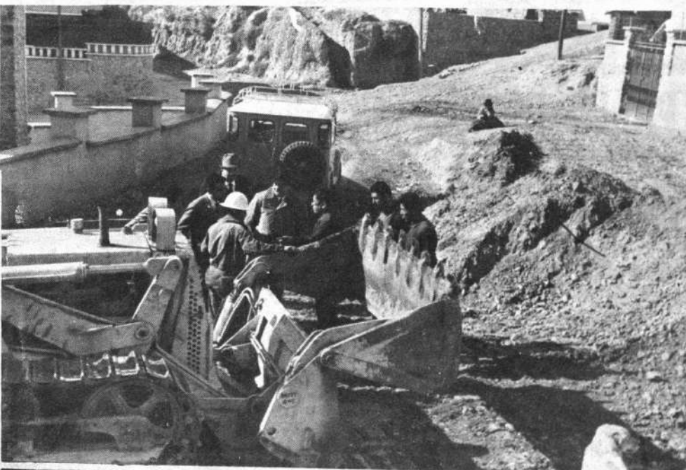
El Alcalde Hugo Suárez Guzmán efectuó ayer una inspección a los trabajos que se están ejecutando en la calle Resegun esquina Chaco, donde se realizan mejoras en dicha arteria para posteriormente pavimentar la indicada calle.
