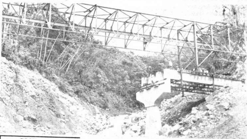
COCHABAMBA.— Estructura metálica del puente que se construye sobre el río "San Pedrito" en los proyectos camineros uno y cuatro de penetración al Chapare. La estructura sirve para el lanzamiento de vigas post-tensadas.
