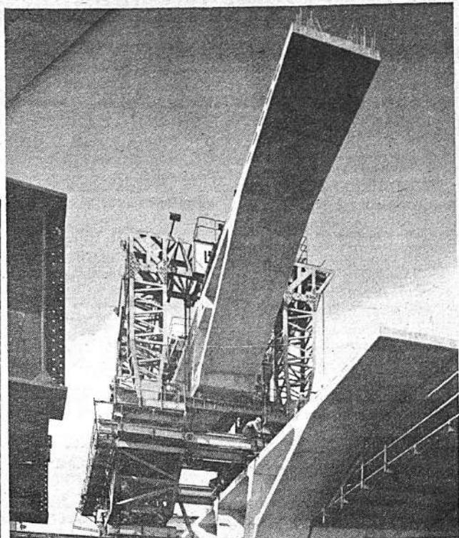
**CARRETERA ELEVADA.**— Una viga prefabricada de hormigón pretensado de 125 toneladas y 28 ms. de longitud, una de las 477 que habrán de utilizarse, es colocada en posición lista para su instalación en la sección 5 de la ampliación de la Western Avenue, en Londres, por un transportador autopropulsado. Será esta la carretera elevada más larga del mundo, con 4 kms. de longitud.
