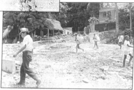
Grietas en caminos vecinales de la provincia Caranavi. (FOTOS: CORDEPAZ)
