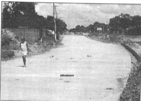
Pavimentación de la Radial 10
