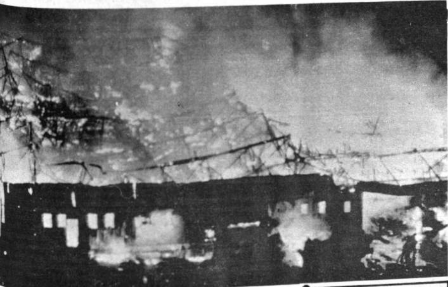
VORAZ INCENDIO.— Fierros retorcidos se derrumban al ser consumidos por las llamas que se extienden rápidamente hasta los techos de madera que cubren almacenes de mercancías en Port City, luego de producirse dos explosiones en el área.
