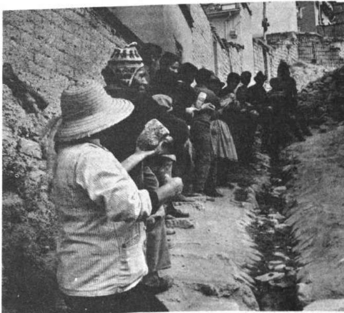
Vecinos de la zona Alto San Juan Lazareto forman una "cadena humana" para trasladar piedras de construcción.
