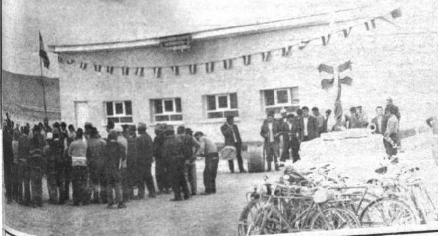
Vista parcial de la nueva escuela de la comunidad de Achica Arriba, en la provincia Ingavi. Autoridades y pobladores de la región se hicieron presente en el acto de inauguración, realizado recientemente. El local demandó un costo de 17 mil pesos bolivianos, aproximadamente.
