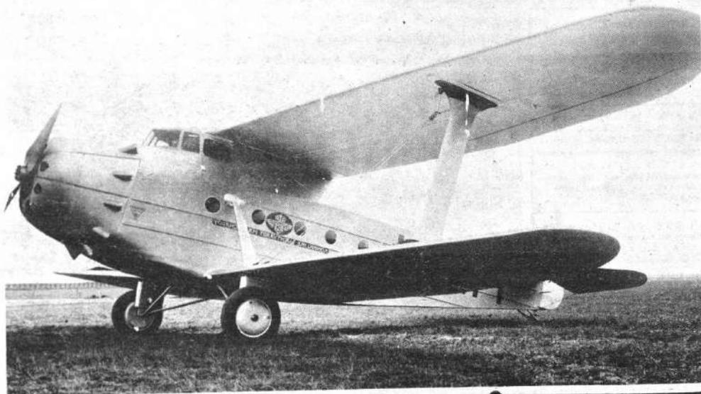
El avión carguero CARLEY utilizado por KLM en la década del treinta, podía transportar 1.100 kilogramos de carga a una velocidad de 155 kilómetros por hora.
