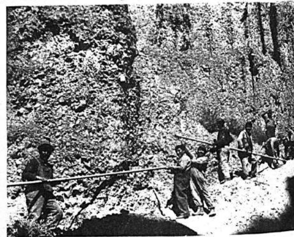
Sobre el cauce del Río Cotahuma los vecinos de ese sector de Tembladerani construyen un puente asesorados por técnicos de Acción Comunal.
