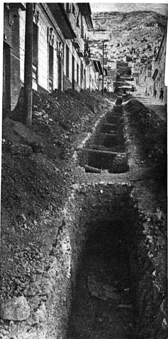
La ciudad despanzurrada en sus vías principales, dificultando el tránsito de peatones y vehículos, significa la ampliación de la red telefónica, la colocación de cañerías de mayor capacidad para el servicio de agua potable y la instalación de una red de alcantarillado que debe renovarse en toda su extensión para satisfacer las necesidades del crecimiento, que en los últimos cinco años ha superado todas las expectativas.
