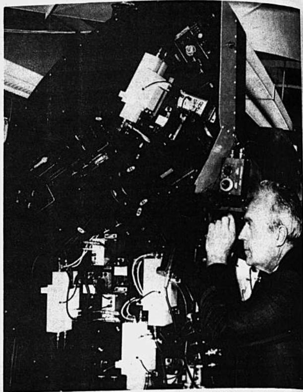
**LASER.**— Un científico mira a través del instrumento telescópico de un laser, que enviará un rayo de luz a través de un telescopio situado en las montañas catalinas, cerca de Tucson. Una pequeña parte de la onda regresará a la Tierra por medio del reflector colocado en la superficie lunar, por los astronautas del laser - 2,4 segundos, los científicos podrán computar la distancia entre la Tierra y la Luna, con gran precisión.
