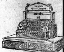
El sistema de Recibo es un sistema que se dota al cliente de un Recibo impreso y exacto, y el hecho de dar este Recibo significa que dentro de la registradora quedan las correspondientes e inalterables anotaciones para el comerciante y el empleado.
