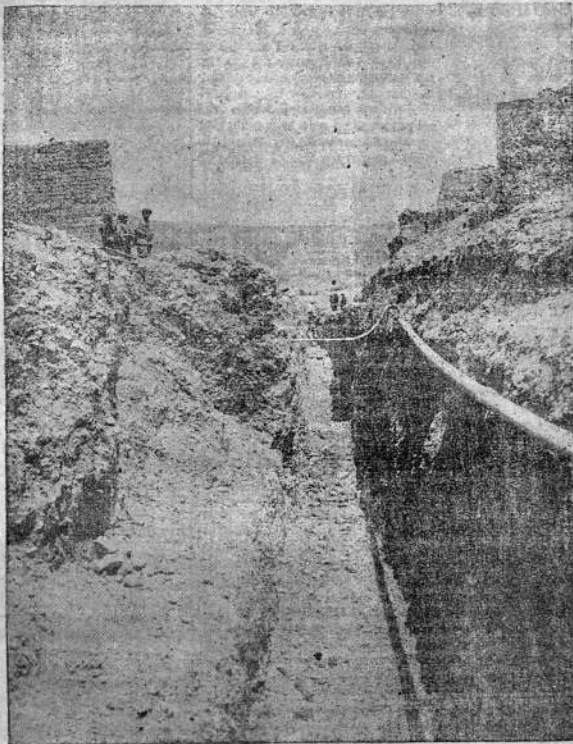
En la calle Armentia. Colocación de la tubería para conducir el agua destinada a las alcantarillas
