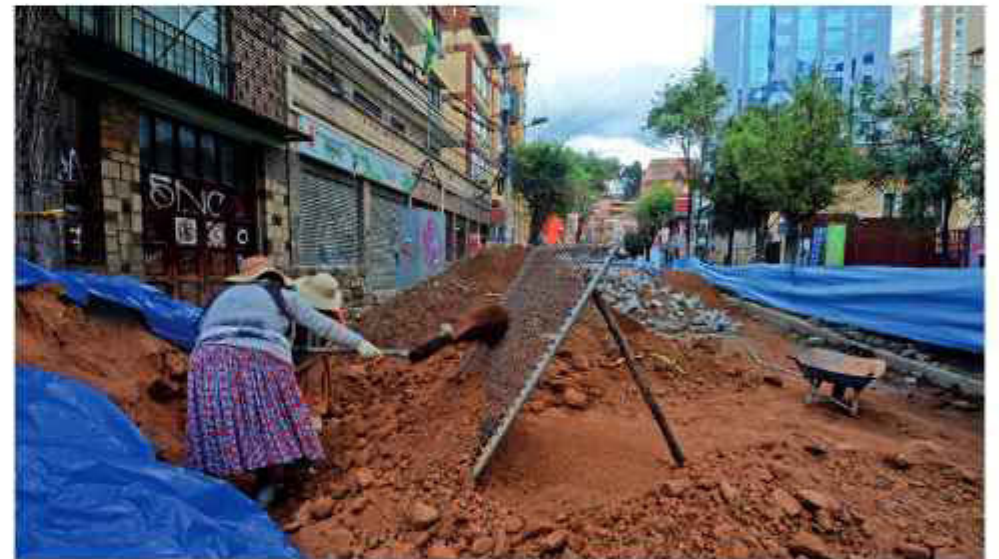
ESCOMBROS. La avenida Ecuador también está cerrada para los trabajos de mejoramiento.
