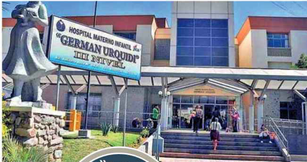
NOSOCOMIO. En este hospital nació la criatura.
