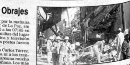
socavamiento del terreno, por la humedad, ya que el superior hay un jardín y la situación se agravó con el agua que desestabilizó el terreno hasta ocasionar el desplome del muro. "El jardín no tenía drenaje y si lo tenía no habría lo cual hizo que las aguas busquen un lugar para salir, a pesar de ellos el jardín se encuentra en una pendiente que ocasionó un fácil desplome", añadió.
