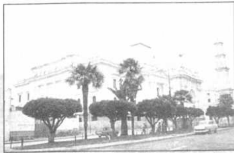
Vista del edificio del Palacio de Justicia
