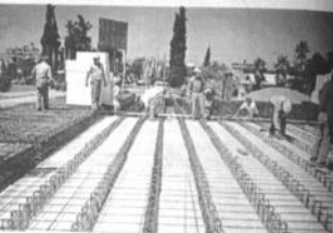
PUENTE DE CALA CALA - COCHABAMBA Empresa Constructora BARTOS
