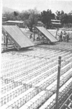
PUENTE DE SACABA - COCHABAMBA Empresa Constructora SERMAC
