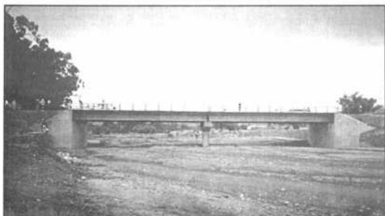
Puente Chaquimayu, en el camino que vincula las ciudades de Cochabamba y Tapera, forma parte de los trabajos orientados al desarrollo alternativo regional.
