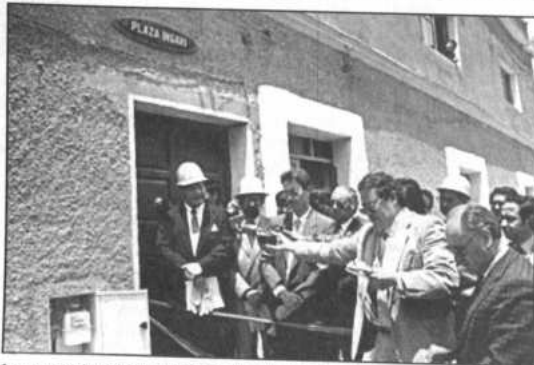
Inauguración de redes domiciliarias de distribución de gas licuado, Oruro
