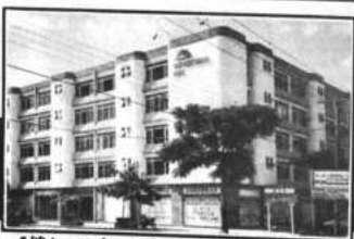
Edificio central en Av. Bazaer, a 100 mts. de El Cristo
