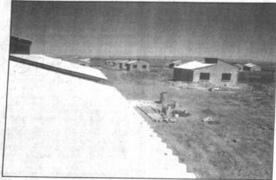
Plan de vivienda en construcción
