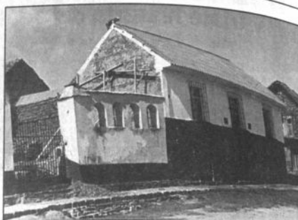
Museo Regional de Aukapata, reciente remodelación de CORDEPAZ.
