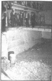
El Alcalde Municipal de La Paz, José Laquis Chequer inspeccionó el estado de las obras de refacción del Teatro Municipal.
